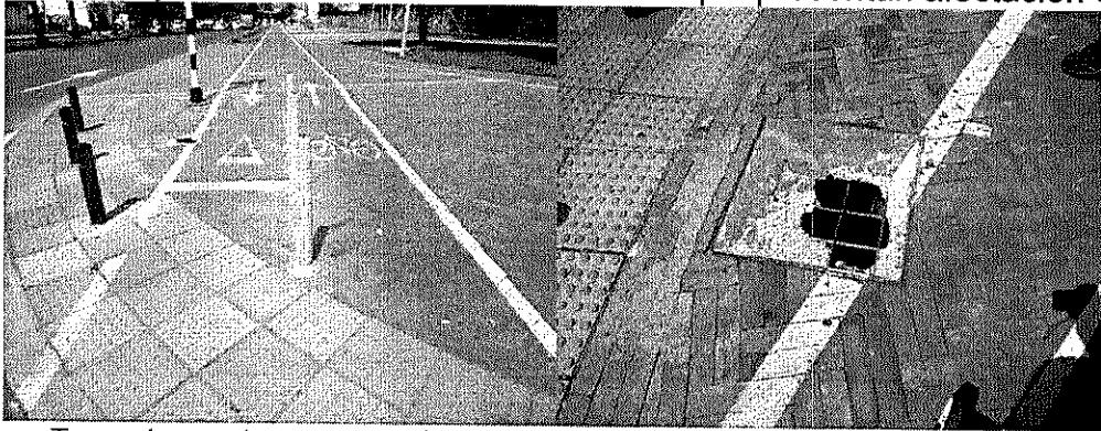
Tapa cámara de paso semáforo en mal estado
