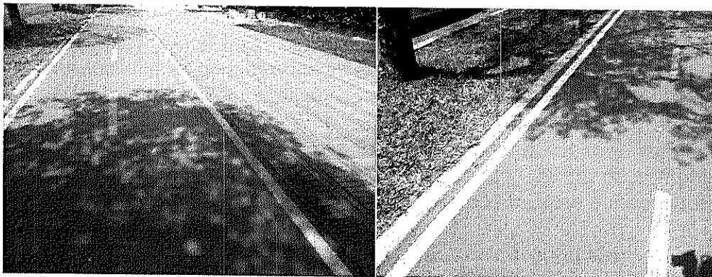
Presencia de fisuras en carpeta asfáltica
